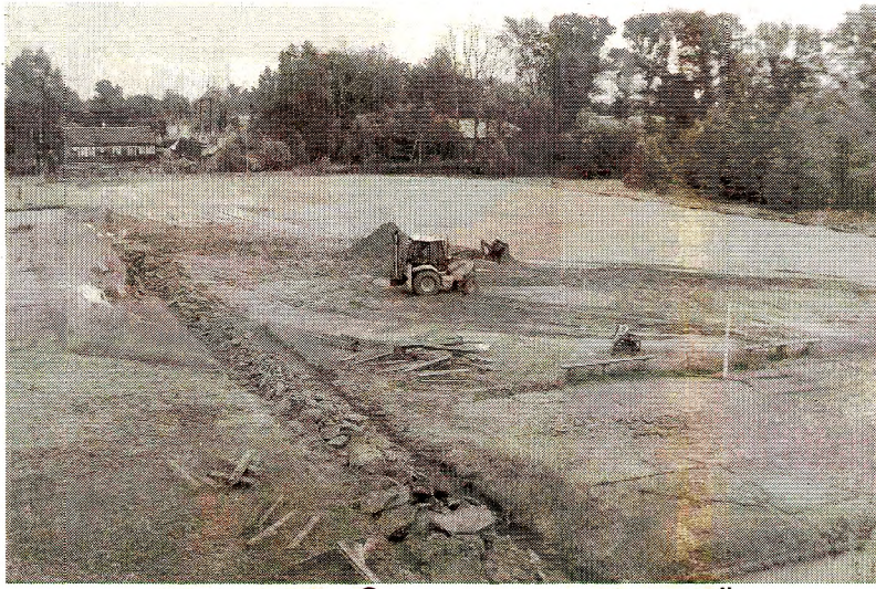
Строительство спортивной площадки у Вохтожской школы
