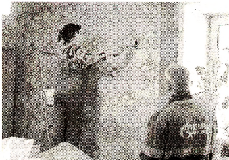
Сотрудники службы УТР в течение пяти дней полностью отремонтировали квартиру ветерана
