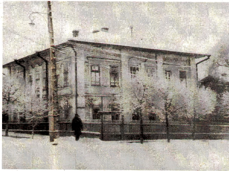
Здание по ул. Карла Маркса, д. 72, где размещались редакция и типография газеты «Коммунар» и «Сельская правда» с 1947 по 1971 год.
