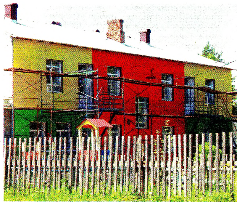
Ремонт детского сада в деревне Юрово
