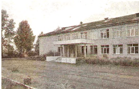
Асфальтированная площадка у здания школы в д. Скородумка
