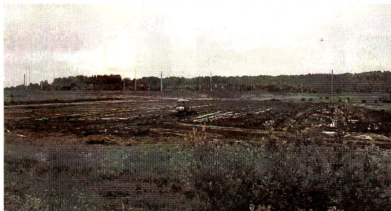
СТРОИТЕЛЬСТВО СТАДИОНА В Д. РОСТИЛОВО. Работы по отсыпке грунтом земельного участка.
