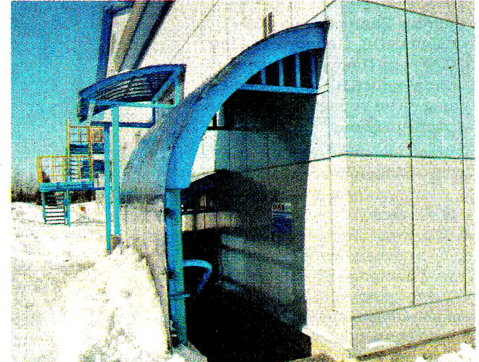
Противорадиационное укрытие расположено в подвале столовой Грязовецкого ЛПУ МГ
