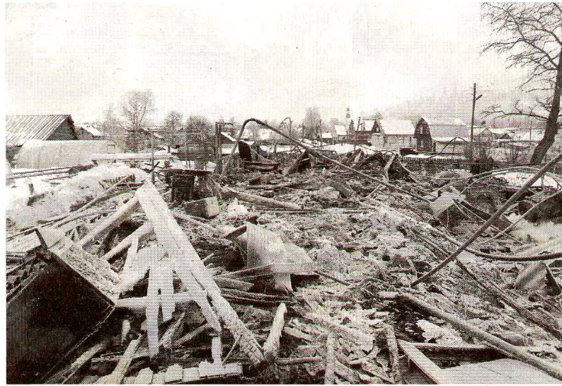
Пожарными дознавателями установлено, что деревянный барак сгорел вследствие замыкания электропроводки. Фото ОНД по Грязовецкому району.
