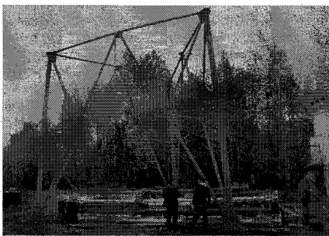
На фото: монтаж башни РПТС Грязовец
