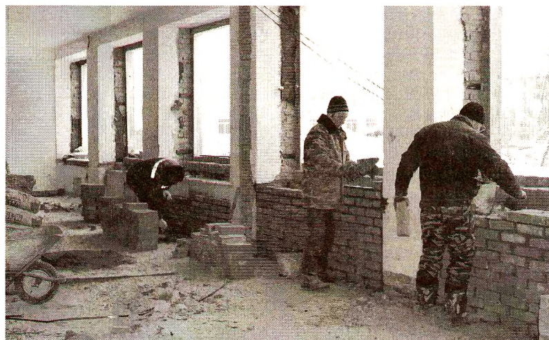
После реконструкции в здании школы будет 49 квартир.
