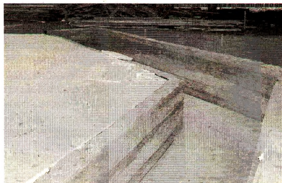
Технологический лоток, в котором разместится основная труба хладагента
