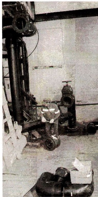
Монтаж нового смесителя
