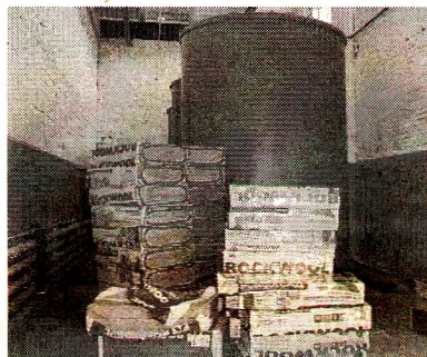
Подрядчик приступил к капитальному ремонту очистных сооружений
