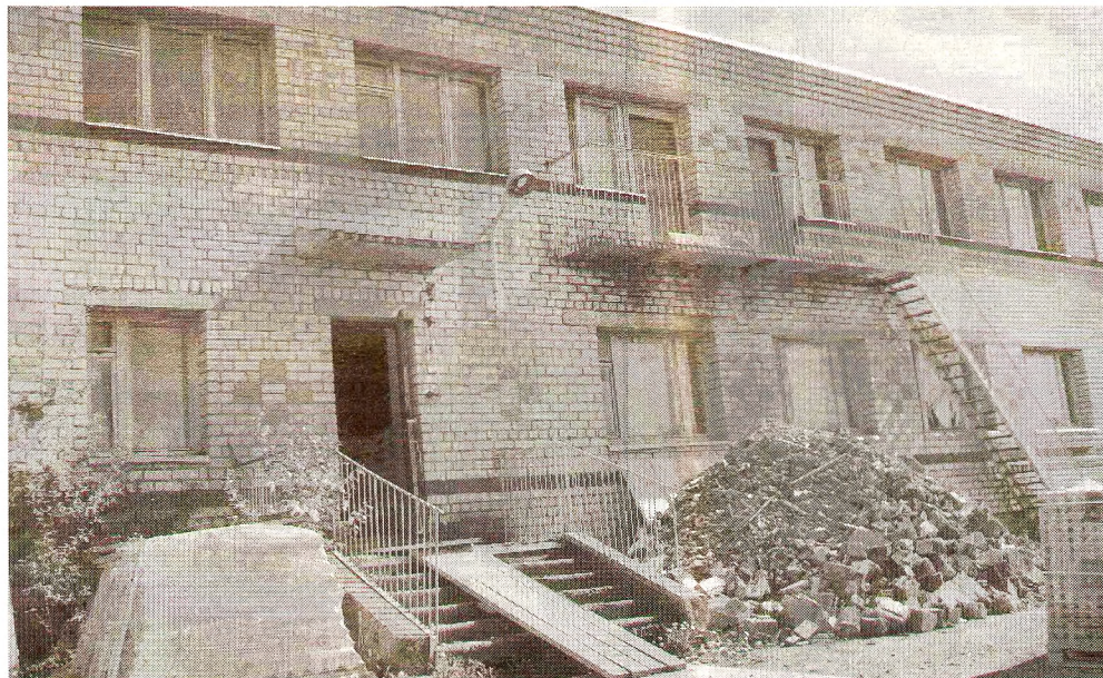
Реконструкция здания бывшего детского сада
