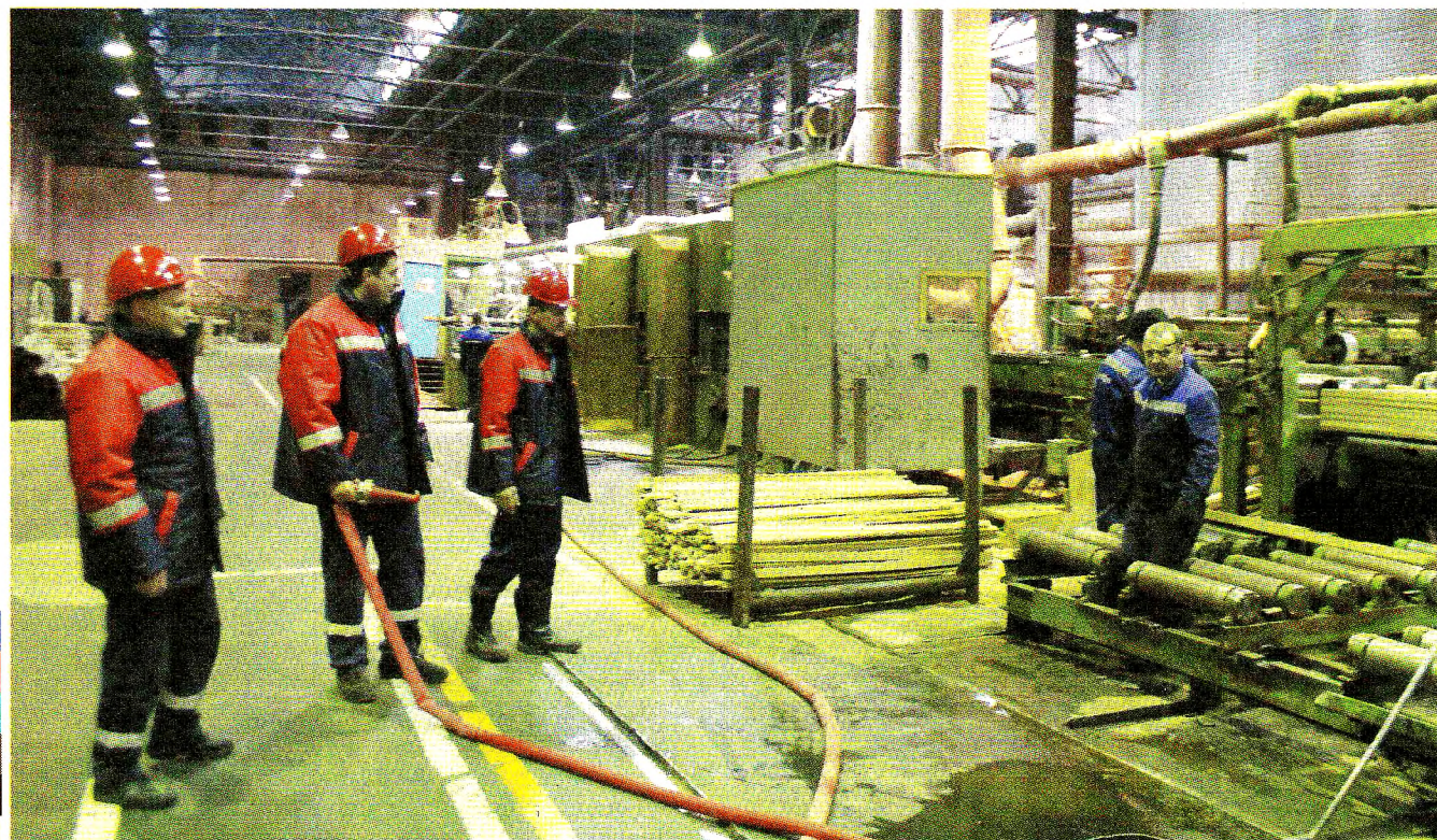
Профилактика возгорания при проведении сварочных работ в цехе ДСП
