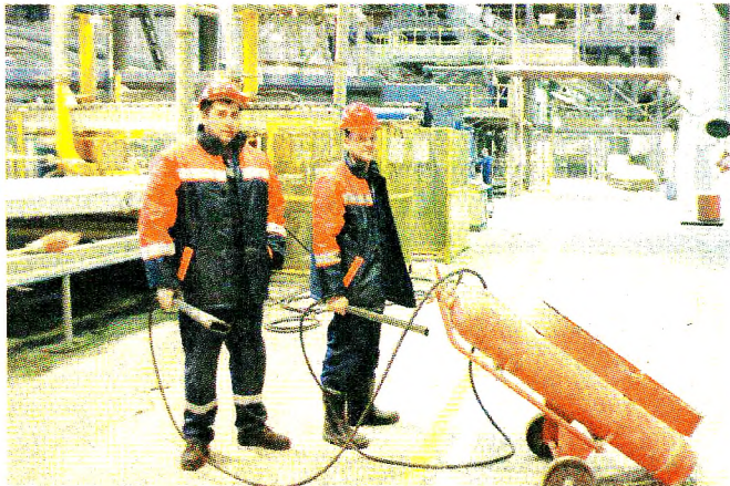
Проверка передвижного углекислотного огнетушителя
