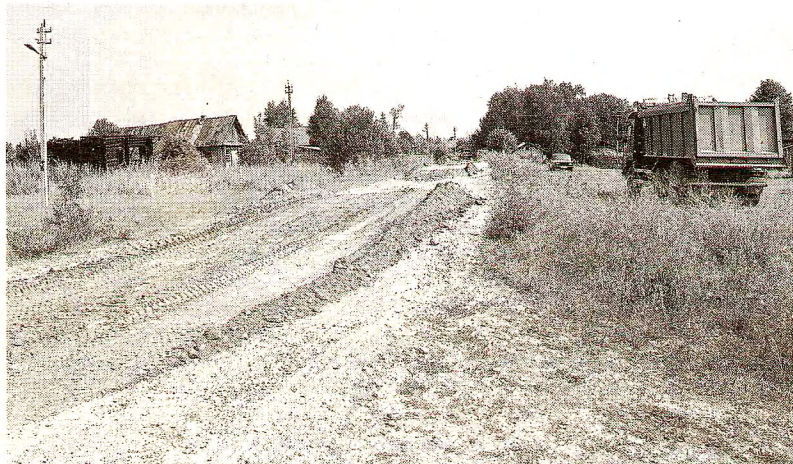
В настоящее время ведется ремонт дороги п. Вохтога - д. Аксёново.
