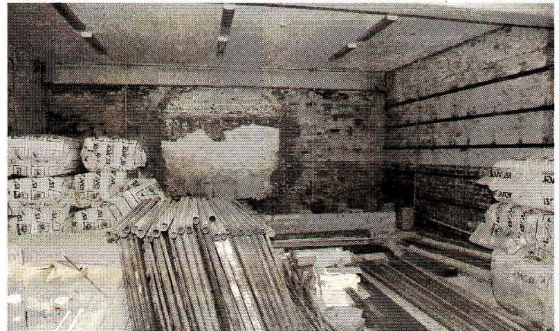
Школа искусств: сделан бетонный пол в зрительном зале, впереди - обустройство сцены, навесного потолка, замена дверей, работы со стенами
