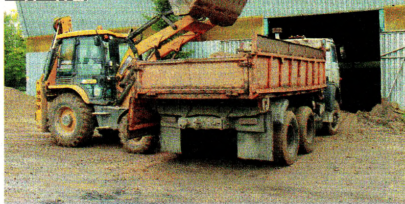
Начаты работы по капитальному ремонту хоккейного корта
