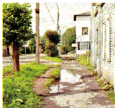
Тротуар по ул. Ленина от дома № 41 до перекрёстка ул. Володарского
