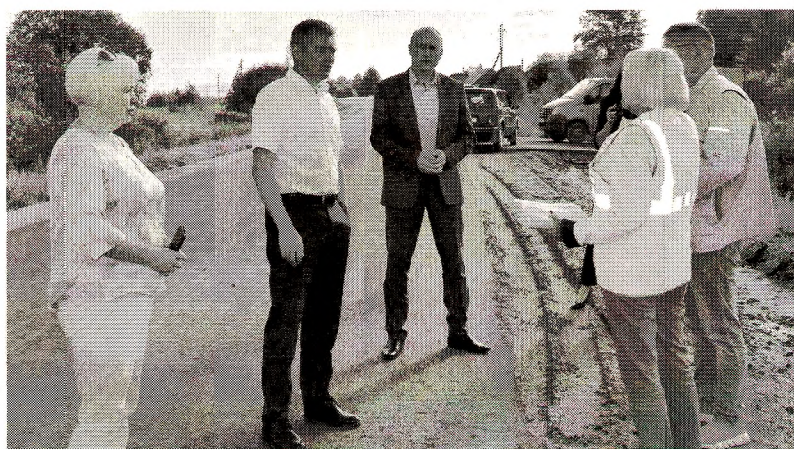
Строители обещают начать асфальтировать участок, ремонт которого запланирован на 2021 год
