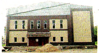
Продолжается ремонт районного Дома культуры
