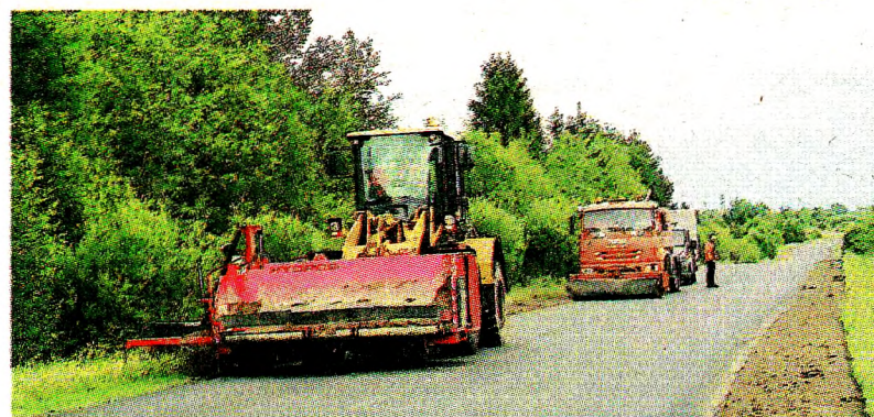
Ремонт дороги Грязовец - Вохтога
