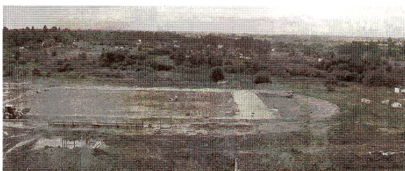
Срок сдачи объекта – до 31 августа 2018 года
