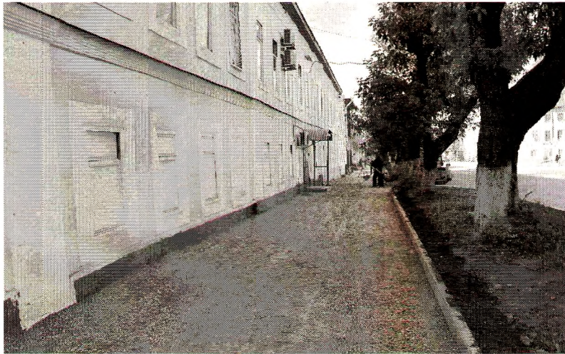
Обустройство тротуара по ул. Ленина от здания универсама до ул. Гагарина
