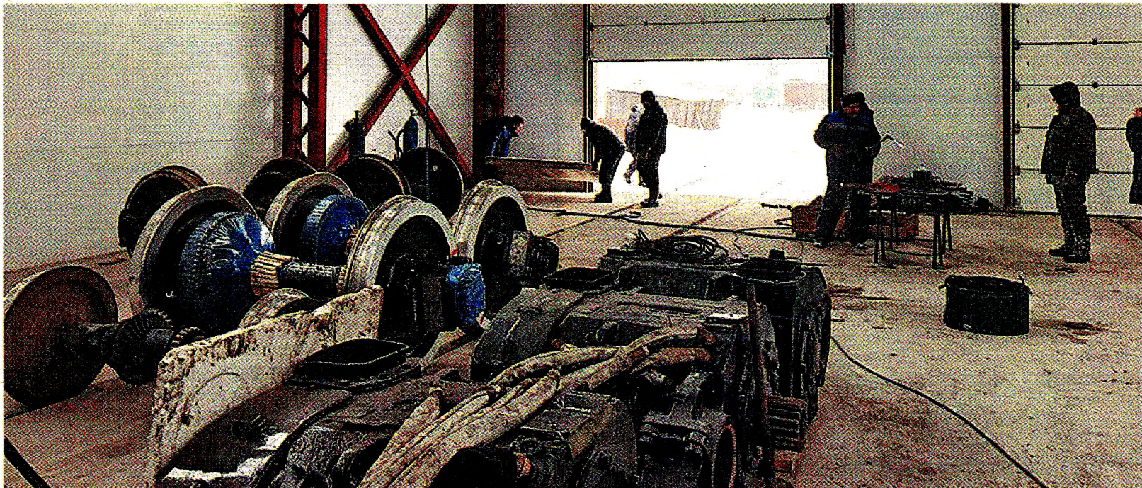
Работы в локомотивном депо
