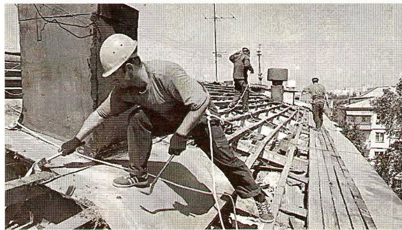
Капремонт в этом году планируется выполнить на территории шести муниципальных образований района
