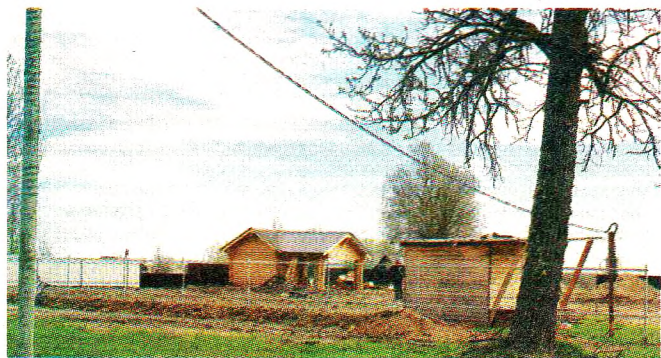
Строительство новых домов
